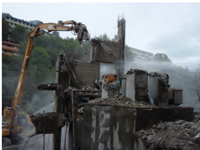
Suivi des travaux de démolition et contrôle de l'envoi dans la décharge adéquate ou dans une filière de revalorisation
