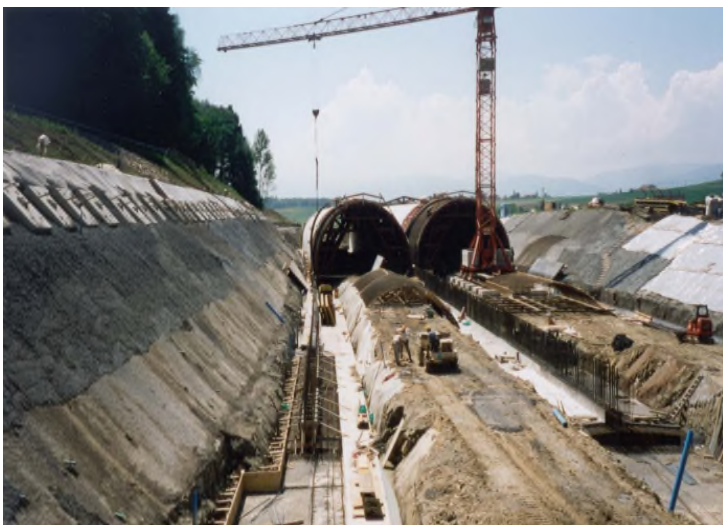
Vue générale après terrassement. Constructions des voûtes
