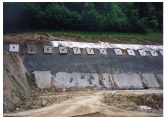
Plaques ancrées pour assurer la stabilité générale des talus
