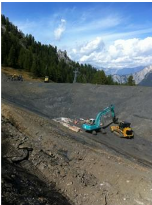
Retenue en cours d'excavation
